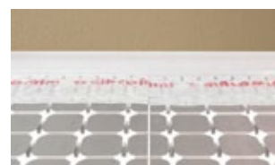
4. Colocação do painel de isolamento R883-1 com camada de alumínio termocondutor acoplado.
