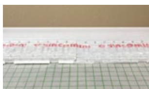
3. Colocação do painel de topo em isolamento R884
