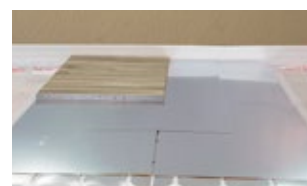
8. Colocação do acabamento final (parquet flutuante)
