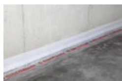
1. Posicionamento da faixa perimetral na parede
