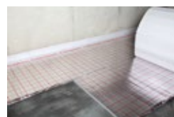
4. Posicionamento do rolo subsequente das placas isolantes
