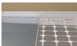
6. Posicionamento da primeira camada de chapa de aço galvanizado
