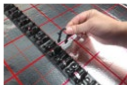
6. Posicionamento da calha de montagem do tubo usando clips especiais
