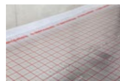
5. Visão geral do posicionamento das placas isolantes
