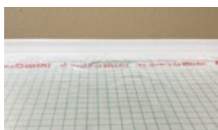
2. Colocação da barreira de vapor / camada de polietileno
