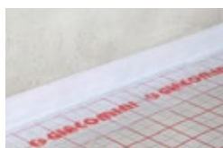
2. Colocação das primeiras placas isolantes
