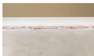
1. Colocação da faixa perimetral
