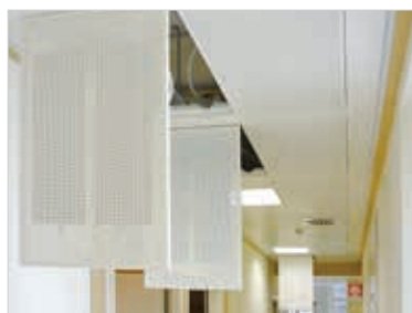
Inspecionabilidade do teto radiante metálico
