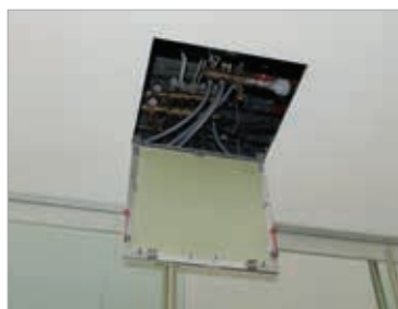
Inspecionabilidade do teto radiante em cartão gesso
